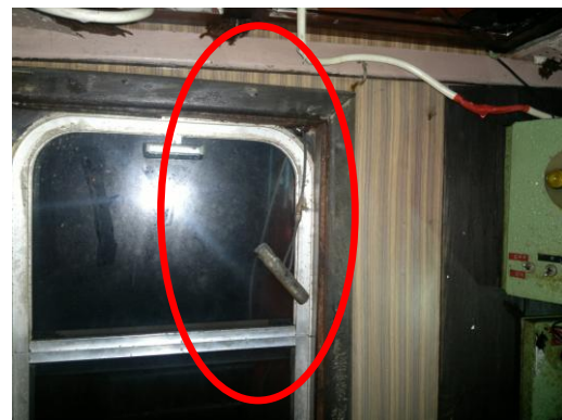
Εικόνα 4: Ο μοχλός απασφάλισης του συστήματος άμεσης απελευθέρωσης ρυμουλκίου στο χώρο πηδαλιουχίας του ΑΡΤΕΜΙΣ V.
