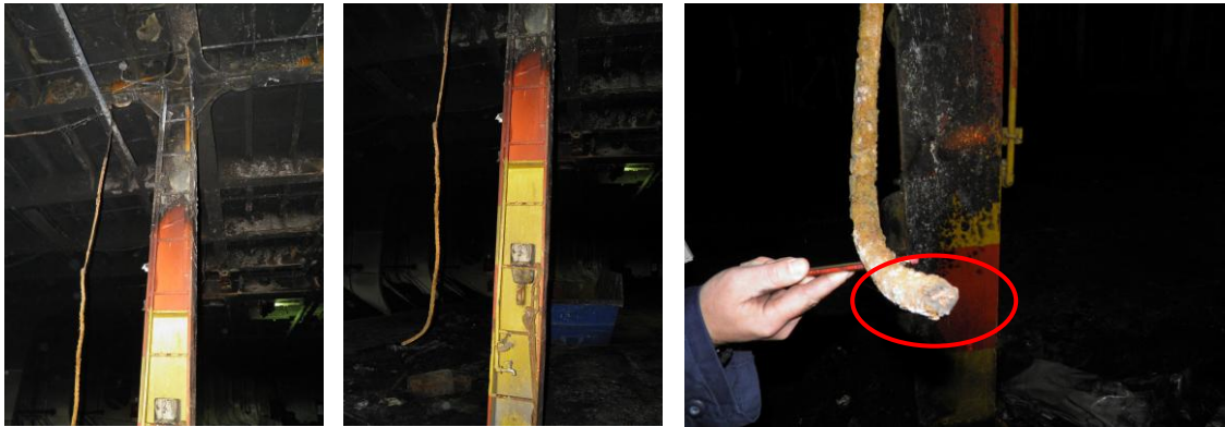
Η πυρμναία πλευρά του στύλου μεταξύ των νομέων 219-221 και το κομμένο καλώδιο.
